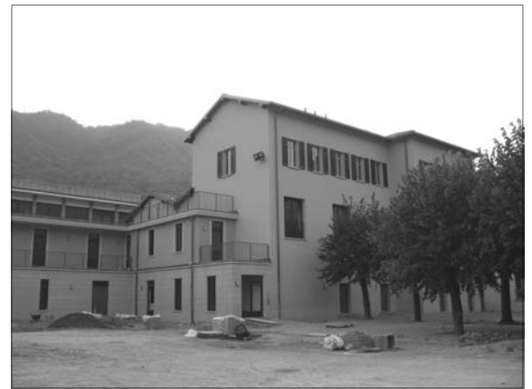
L'Oratorio oggi al termine dei lavori
